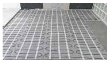
**Otros métodos de construcción:** en caso de calentamiento directo de la cubierta, se recomienda el uso de un compuesto de nivelación de suelo para los siguientes tipos de cubierta: pisos de listones de madera, parquet laminado, PVC, resina sintética y alfombras de piso instaladas.
